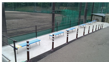
▲新設した観覧エリア(3塁側)
