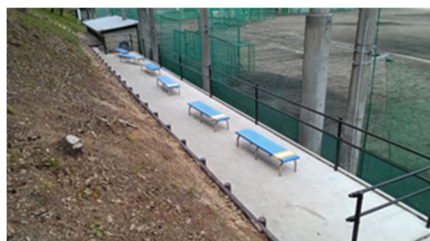
▲新設した観覧エリア(1塁側)
